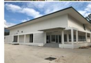
อาคารโรงชีวภัณฑ์ (ใหม่)
